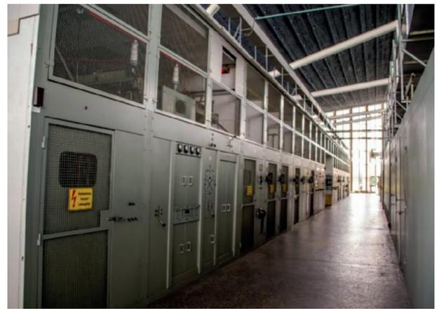
Die Stromversorgung von 2 × 35 kV von unterschiedlichen Kraftwerken wurde auf 10 kV in diesen Schaltschränken umgesetzt
