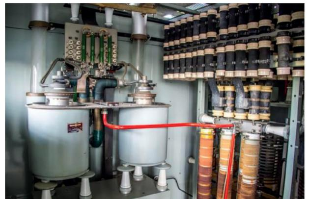
Endstufe 400 kW, 2 × Triode „Vapodyne“. Die Senderöhren sind kopfüber mit der Anode nach unten in den Kühlwassertöpfen montiert. Rechts und links gehen von den Töpfen der Siedewasser-Kühlung die transparenten Rohrstücke weiter in den Kühlwasserkreislauf. Die oberen Anschlüsse der Sendetrioden sind die Heizungsanschlüsse. Diese wurden geheizt mit einer Spannung von 16,5 V und 300 A. Dann folgte das Steuergitter der Röhren. Die rote Leitung war die Hochspannungszuführung für die Anodenspannung
