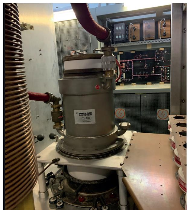
Eine der beiden Keramik-Senderöhren Thomson TH539 Tetrode 1,25 MW, Anodenspannung 13 kV, Heizspannung 30 V und 900 A
