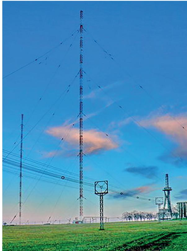
Charakteristisch für das 117 ha große Antennenfeld waren die als abgeschirmte Reusenleitungen ausgeführten Speiseleitungen und die Einhausungen am Antennenfuß für die Anpassglieder
