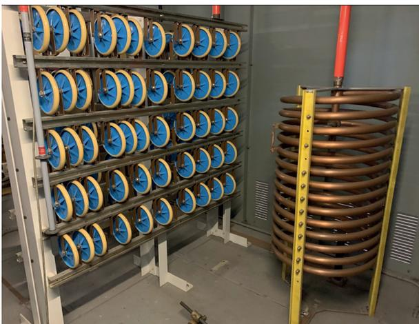
Eine Batterie von Kondensatoren am 1000-kW-Sender
