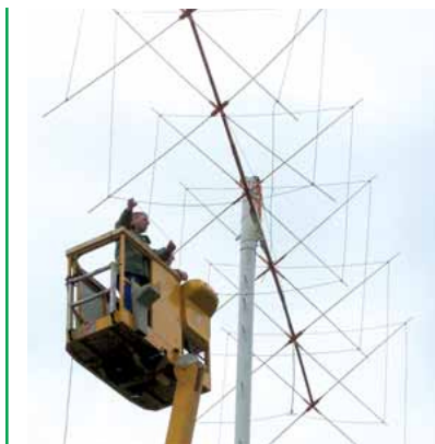
Reparatur der 6-Element-10-m-Quad bei DFØHQ in Ilmenau
