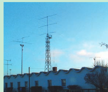
DP9A Antennen: Mast vorn: 5-EL. 10 m, Stahlgittermast: 5-EL. 15 m, 4-EL. 20 m, 2 EL. 40 m, Mast hinten: A4S
