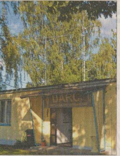
Die großen Antennen auf dem Dach brauchen die Amateurfunker zum Kommunizieren.
