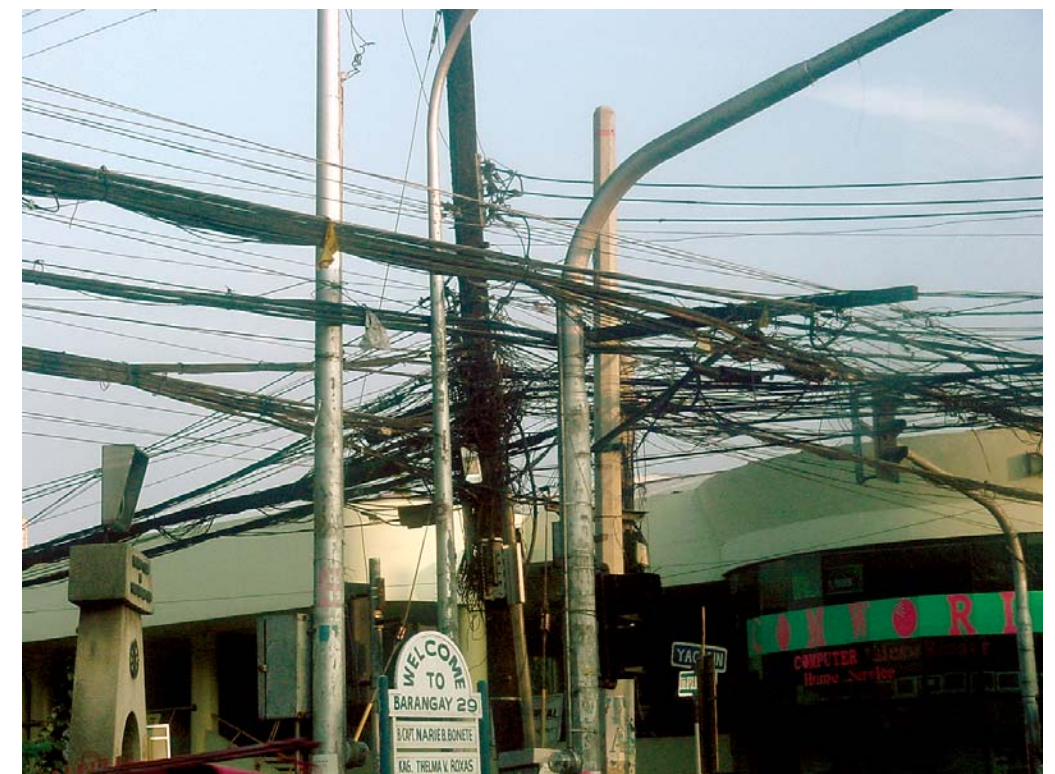
Bild 3: Funktionsfähige Elektroinstallation mit QRN-Garantie
