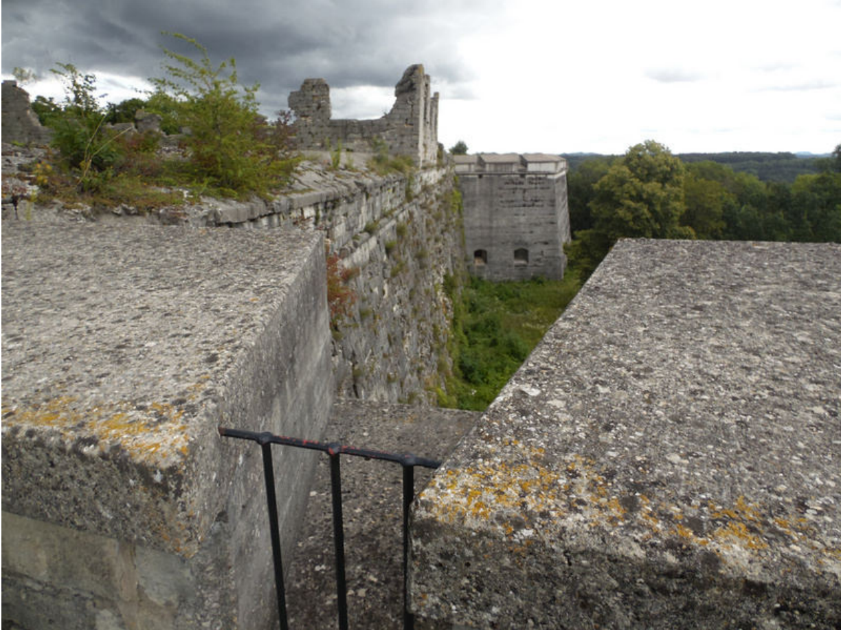
Blick von der Bastion Kersbach auf die Bastion Glatzenstein
