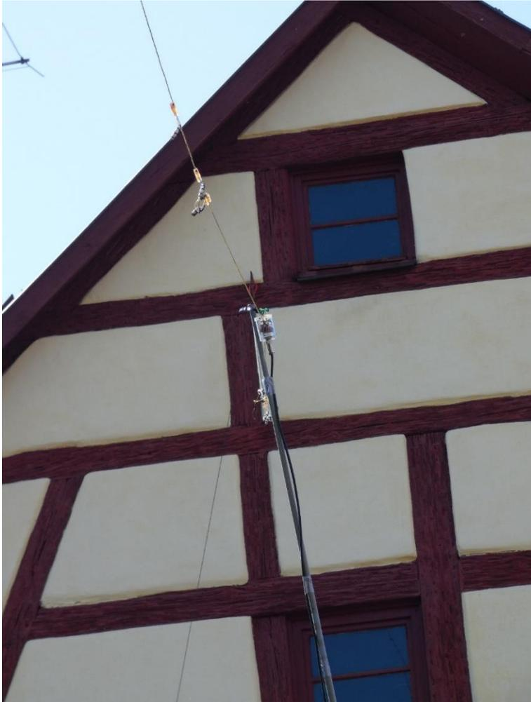
Der eine Schenkel wurde über die oberste Strebe im Glockenturm gespannt. Der Andere wurde über einen Karabiner als Umlenkpunkt nach unten gespannt.
