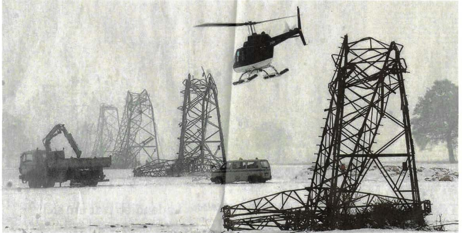
Wie Streichhölzer knickten 2005 im Münsterland Strommasten um, als die Schneelast für die Stahlskelette zu groß wurde. Tagelang waren Menschen ohne Strom.
