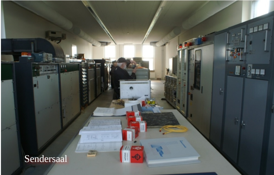
4x KW-Sender. Gesendet wird nachts mit 300W, am Tage mit 1 KW
