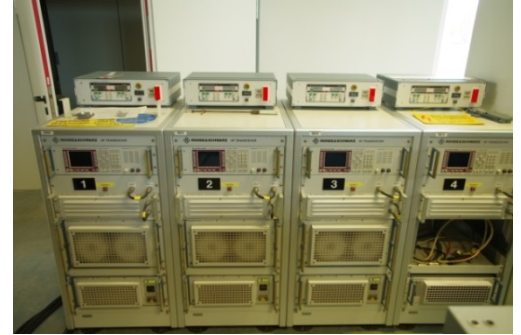
4x KW-Sender. Gesendet wird nachts mit 300W, am Tage mit 1 KW
