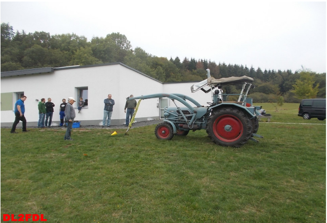
Die Erdspieße der Antennen Abspannung müssen mit Maschinenkraft gezogen werden.
