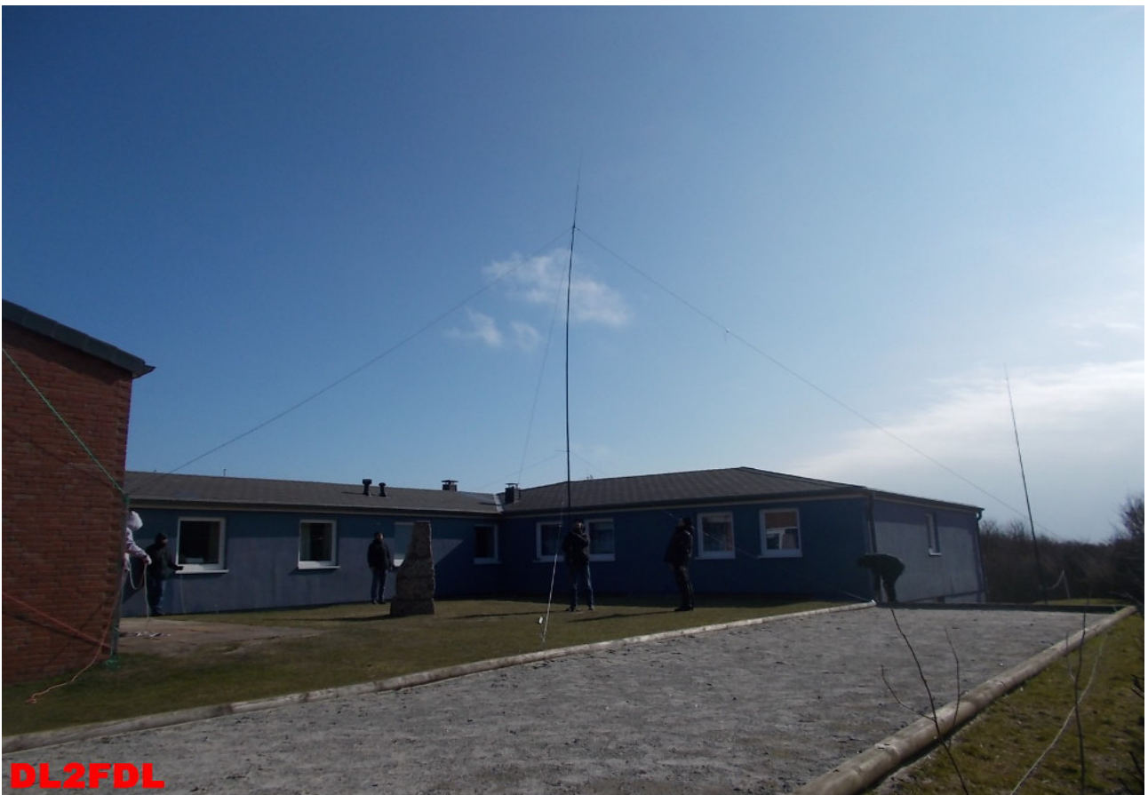
Aufbau einer Triple Leg Groundplane Antenne.
