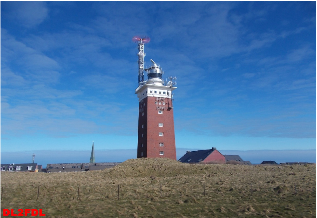
Der Leuchtturm mit Radaranlage und Peilstation. Standort DB0HEL MMDVM Relais
