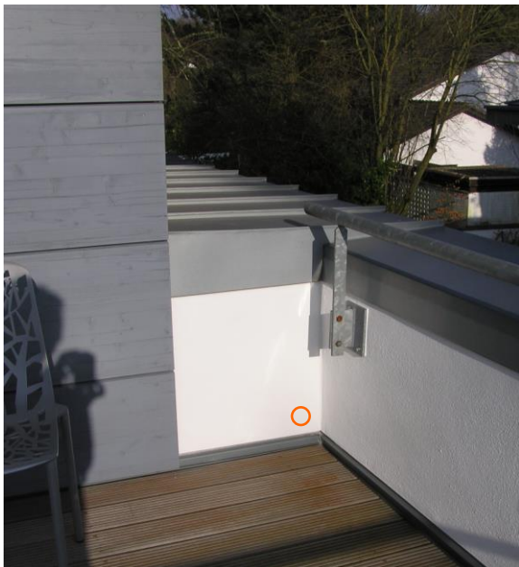
Bild 1a: Bereich der Dachterrasse mit markierter Position (roter Kreis) für die Durchführung des Speisekabels aus dem Kriechspeicher auf die Dachterrasse zum Aufstellort der Vertikalantenne
