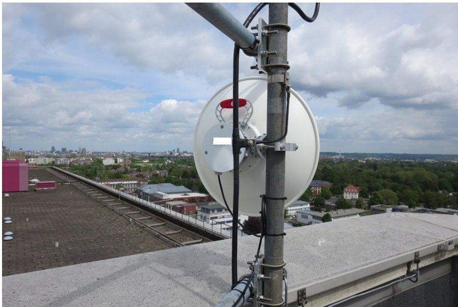
montierter Spiegel am Tragrohr
