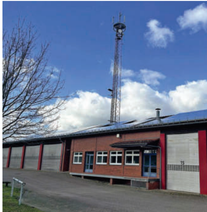
Objekt der Begierde: Am Funkturm des Heidekreises auf dem Gelände der Feuerwehrtechnischen Zentrale soll eine sogenannte Relaisfunkstelle errichtet werden. Mit ihrer Hilfe soll analoger Funkbetrieb selbst bei totalem Stromausfall möglich sein. Foto: Meyland
