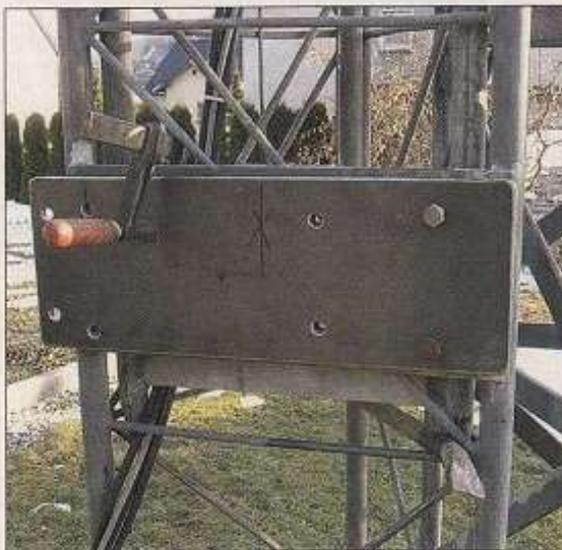
Zur Aufnahme der Winde muss eine etwas größere Stahlplatte mit der Platte am Mast verschraubt werden.
