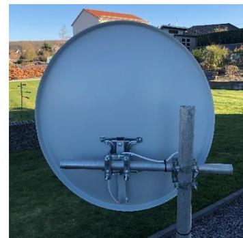
Danach wurde die Antenne montiert, ausgerichtet/justiert und dann das Kabel vom LNB mit der Speiseweiche ins Shack verlegt → fertig. Nun bin ich über QO-100 empfangsseitig QRV.
