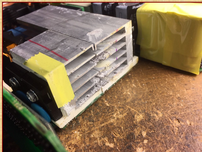
Vom Salz beschädigtes Schaltnetzteil
