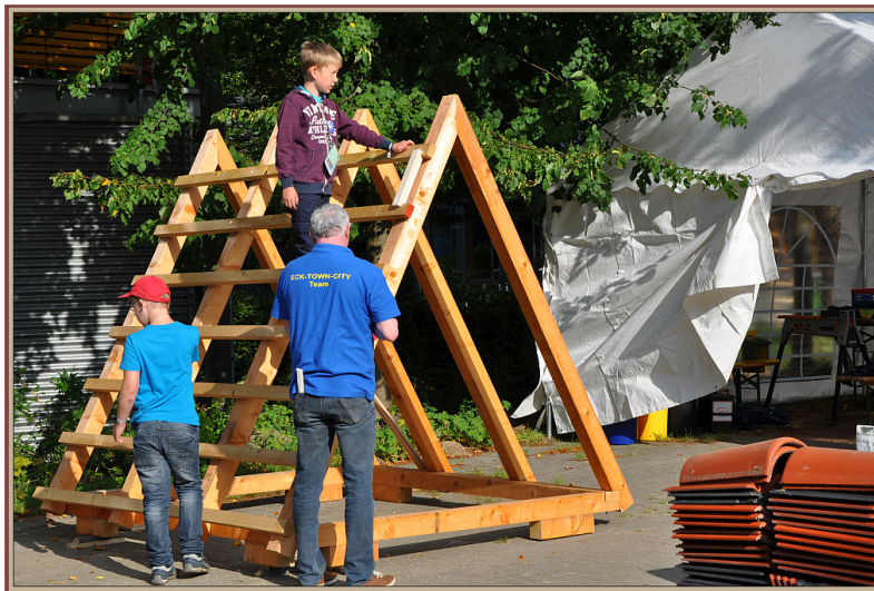
Ein kleiner Dachstuhl wurde eigenverantwortlich errichtet und später mit Ziegel eingedeckt
