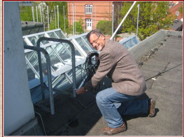
Antennenabbau Reiner, DL7KL
