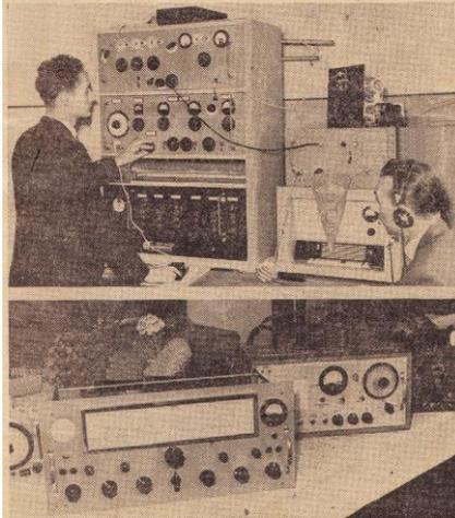
Bernhard Schirmmacher (links) vor seiner Funkstation, die auf dem 10-, 15-, 20-, 40- und 80-Meter-Band arbeitet, zur Phobie und Telegrafie verwendet werden kann und in alle Erdteile reicht; das ideale Gerät für Radioamateure. — Auf dem unteren Bild einige der meist selbstgebastelten Funkgeräte und -zubehöriteile. Das vorn abgebildete Gerät — ein Doppelsuper für Kurzwellen — ist ein außerordentlich klares Empfangsgerät. (WAZ-Bilder: Weingandt)
