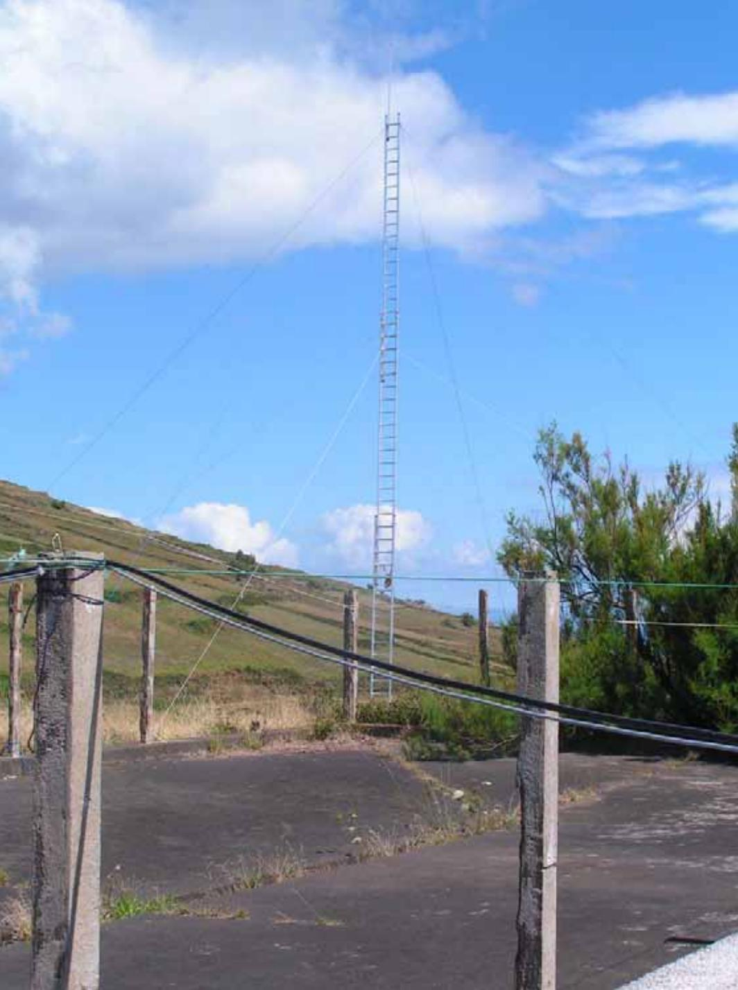
**Weil mit dem Schiff einige GFK Rohre, die für eine 80m Vertikal gedacht waren, nicht pünktlich angekommen waren, hatte Antonio vor Ort eine 15m Leiter gekauft. Mit einem 2m Rohr verlängert und mit einem 45m Kupferdraht als Dachkapazität belastet, war sie ohne Matchbox auf 160m zu gebrauchen. 160m haben wir aber kein QSO gemacht, es war einfach nur tot . Für 80 hat man den Draht soweit aufgerollt, bis das SWR 1:1 war.**
