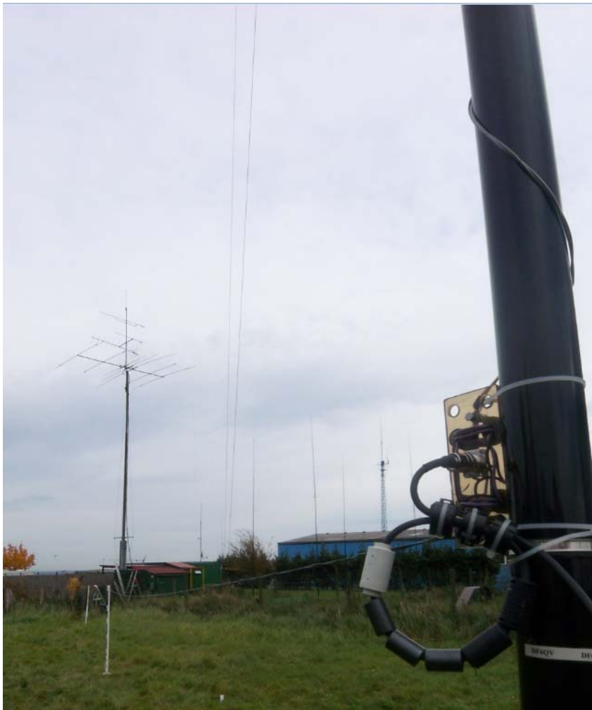
Fußpunkt eines 80m 4SQ Elements, Blick entlang des elevated Radials , im Hintergrund der FB73 und die 4SQ für 40m
