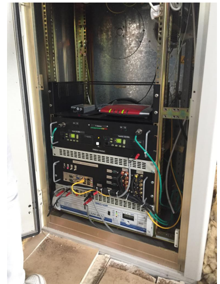
Abbildung 6: DB0BOH – 2021 nach dem Umbau
