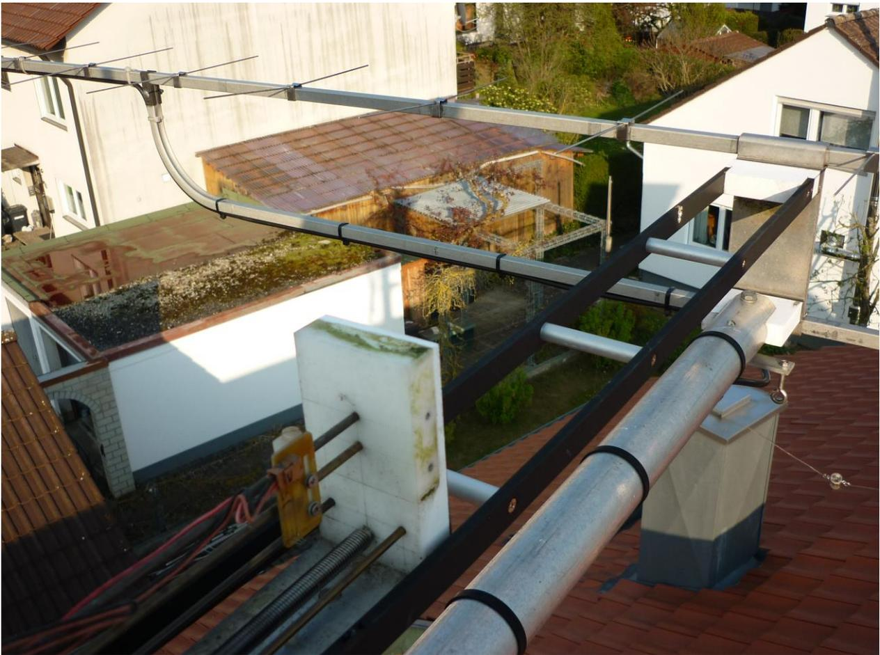
**Detail-Foto 5** zeigt die beiden Kunststoff-Flachstangen (6mm schwarz) welche zueinander durch Abstandbolzen (10 mm Alu-Rundmaterial) miteinander verschraubt sind. Hierdurch erhält die Antenne einen stabilen Seitenhalt und ist stabil gegen Windeinwirkung.
