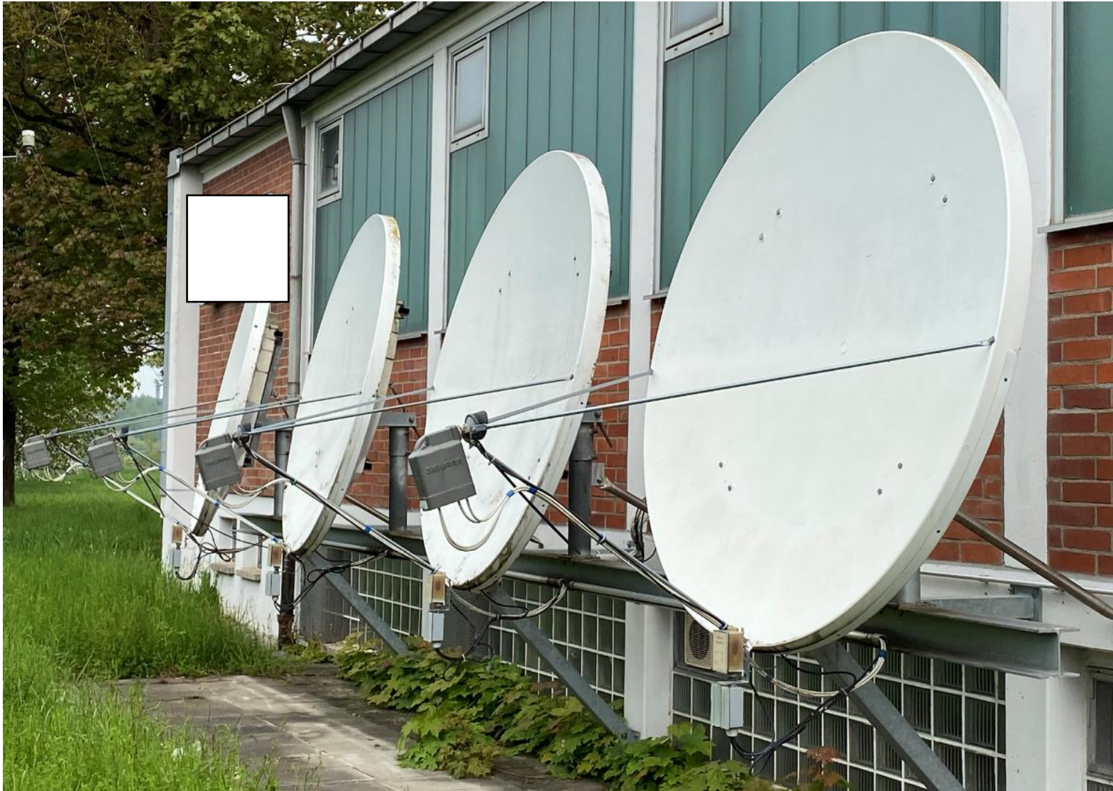
Kopfstation mit vier Spiegeln 1,8m Höhe und thermostatisch geregelter Spiegelheizung
