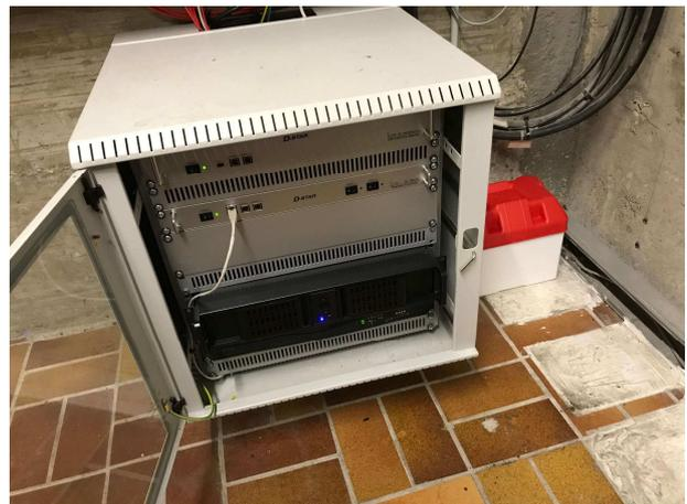
In ein paar Tagen wird auch noch das neue DMR-Relais DBØGK an den DMR-Server bei DBØLBX angeschaltet werden. Die 5,7 GHz Richtfunkstrecke zwischen DBØGK und DBØLBX ist schon aufgebaut und der Relaisverantwortliche von DBØGK ist gerade dabei das DMR-Relais mechanisch in den Outdoorschrank einzubauen.
