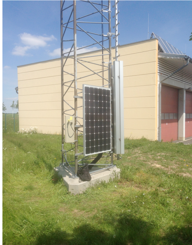
Solarstromversorgung
