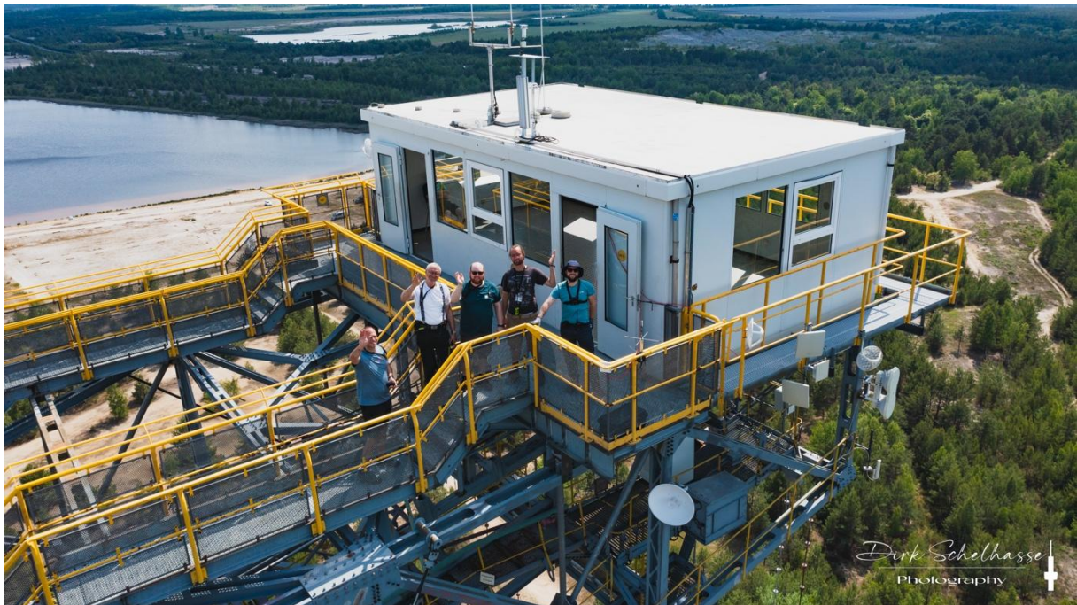
(Team zum Antennenbau auf der Abraumbrücke F60, Foto: Dirk Schelhasse, DM7DS)
