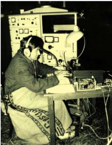
**Bild 2:** Lothar, Y24UK (DL3TD), sitzt im Zelt mit Transceiver und SS-1000 Endstufe. Seine Füße sind von einer Decke eingehüllt, unter der ein 1-kW-Heizlüfter seinen Dienst tut ... So kalt war es 1986 im Juli! Der vor dem Transceiver stehende Kasten enthält mehrere 3 kHz breite schaltbare Quarzfilter, die direkt in die Antennenleitung der 40-m-3-Ele.-Quad geschleift wurden, um die IM-Eigenschaften des Empfängers wirkungsvoll zu verbessern
