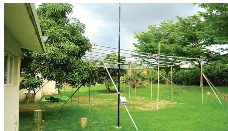
Bild 3: Vertikalantenne, aus GFK-Mast und Koppler, am Gerüst befestigt
