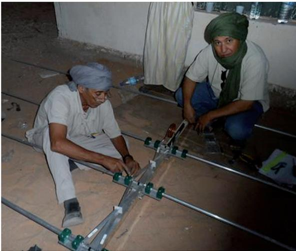
Azman, SØ1AH, und Naama, SØ1A, bauen die 59+, eine 10-EL.-Beamantenne für fünf Bänder von dem spanischen Hersteller EAAntenna zusammen. Mit nur 100 W: S9-Signale bis nach Japan und Australien
