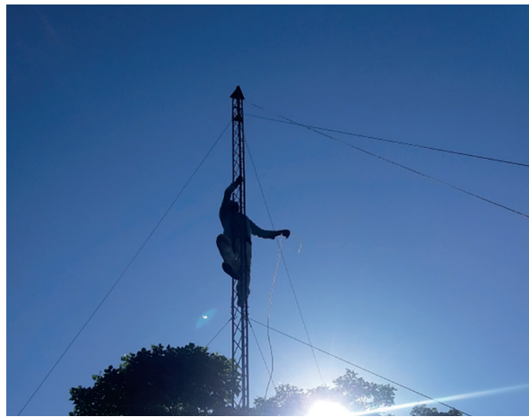
Bild 4: Montage eines 20-m-Dipols
