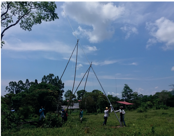
Bild 5: Aufstellen eines der vier Rohrmasten
