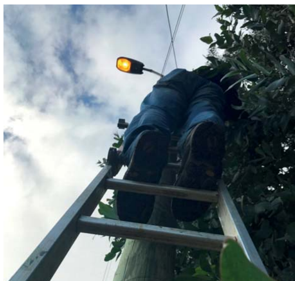
Fehlersuche an der Straßenbeleuchtung
