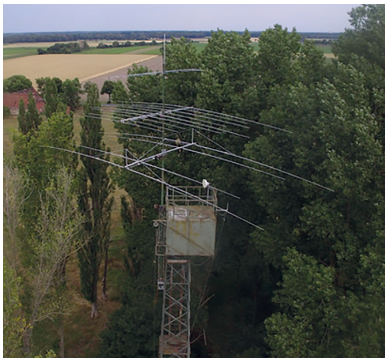
Die Antennenanlage bei DKØAX aus der Luft (Bild: DB5WL)
