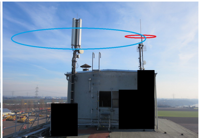
Sicherheitsabstände überschneiden sich nach Montage von Sektorantennen
