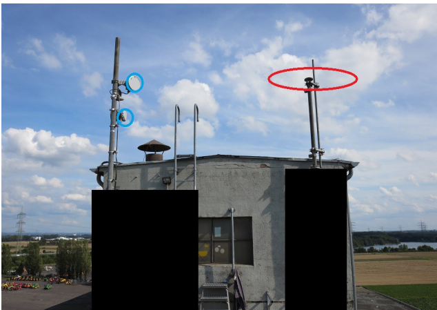
Sicherheitsabstände sind ausreichend entfernt
