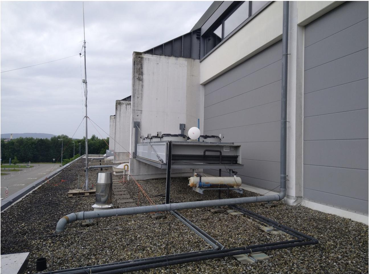
*HAMNET-Anbindung der Halle A1 über Richtfunkspiegel (Bildmitte auf der Klimaanlage)*
