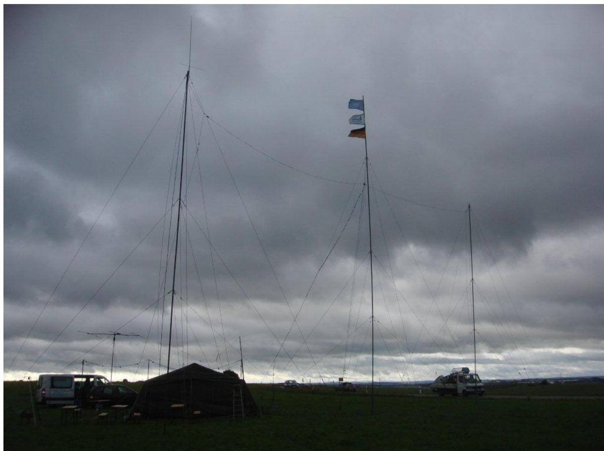
Wir sicherten mit den Eisenstangen und langen Leinen das Zelt. OM Ingo und OM Jörg fuhren kurz weg und richteten die vier verbogenen Steckrohre. Danach bauten wir die Antennenmasten wieder auf und schlugen die langen Zelthäringe zur Sicherung der je 12 Abspannleinen ein. – Schließlich lassen wir uns doch vom Wetter nicht einschüchtern!
