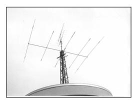
Die alte Antennenanlage (links), bestehend aus einer 25-Ele.-Yagi für 70cm, einer 12-Ele.-Yagi für 2m und einem FB53 von Fritzel für 20/15/10m mit einem Speziell angefertigten Rotor-System zum getrennten Drehen der UKW und KW Antennen wird durch eine Log-Periodische Kurzwellenantenne für 10m bis 20m und je einer Yagi-Antennen für 2m und 70cm sowie eine Groundplane für 2m, 70cm und 23cm ersetzt (rechts).
